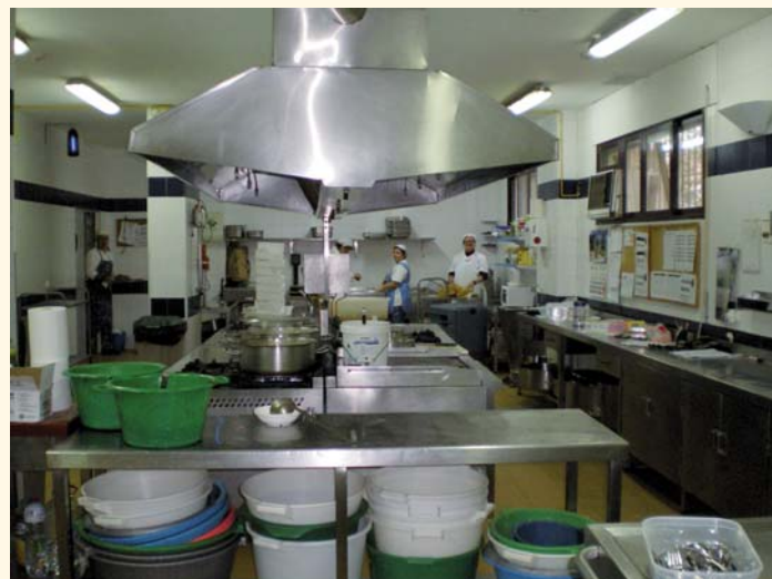
Ampliación y reforma de Cocina
