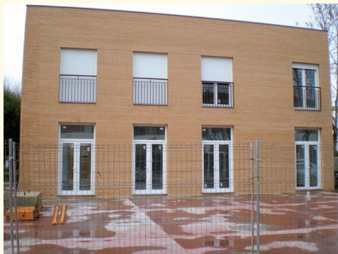
Ampliación de Residencia para Personas Gravemente Afectadas
