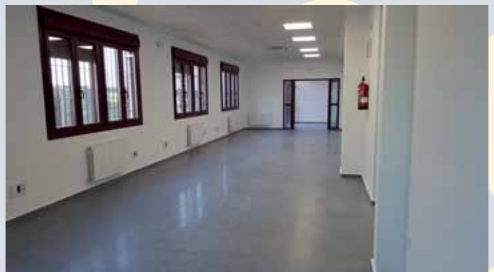
Zona de la ampliación del Servicio de administración
